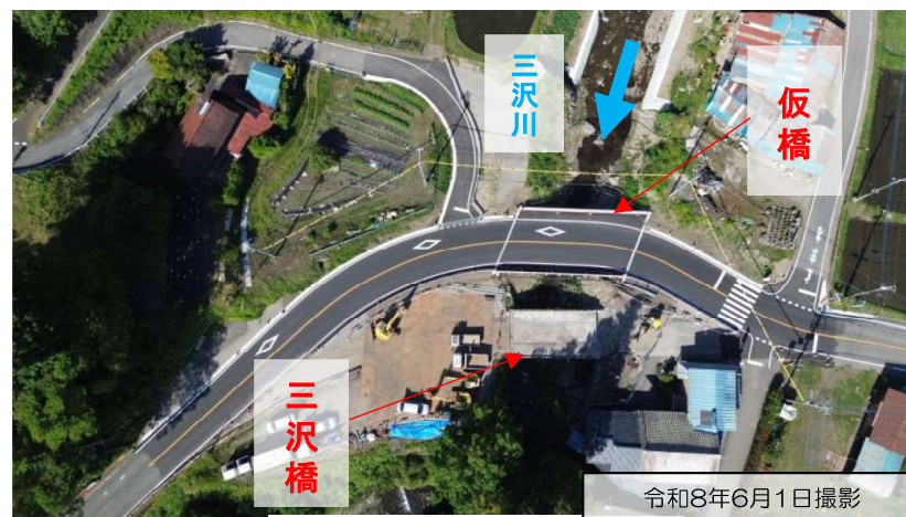
三沢橋取壊工 施工状況
