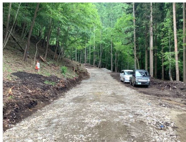
④ 撮影日：R8. 6. 5 ◆ No.43付近 道路盛土転圧状況
