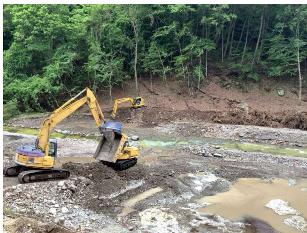
③ 撮影日：R8. 6. 5 ◆ 渡河工 仮締切施工状況
