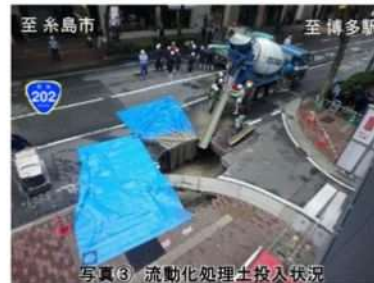
写真③ 流動化処理土投入状況
