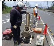
(貫入試験による調査)
