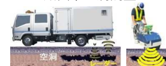
路面下空洞調査
