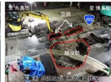
写真④ 空洞反応箇所の確認状況
