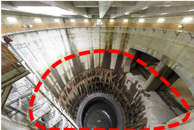
第1立坑から調圧水槽への流入状況
