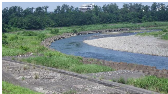
写真 6-19 水制工 (足利市岩井付近)
