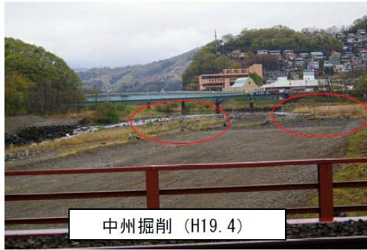
写真 6-4 出水時に流水が水路を流れ、右岸への偏流が攪乱されるようになった。
