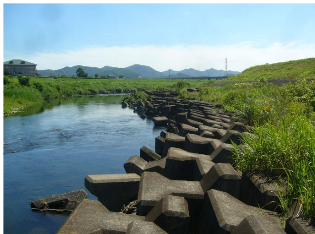
写真 6-17 根固工（足利市岩井付近）
