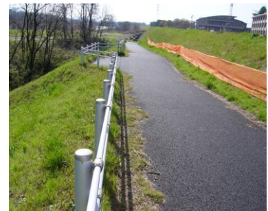
写真 6-9 緩傾斜の坂路
