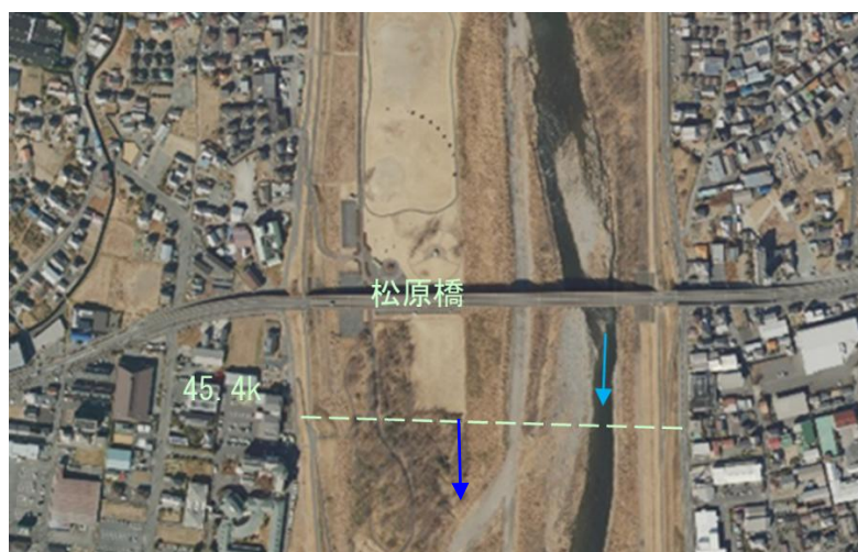
写真 3-1 中州と水衝部の状況 (R7.1)
