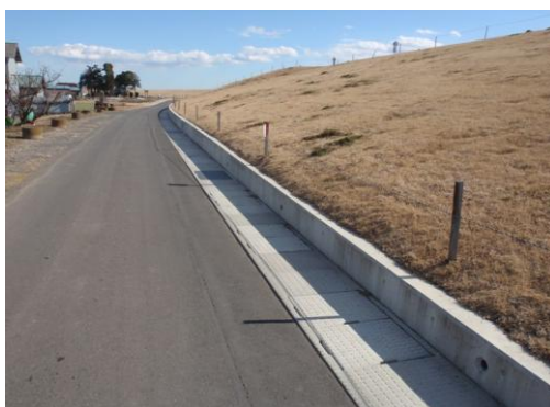
写真 6-10 コンクリートブロックによる堤脚保護工
