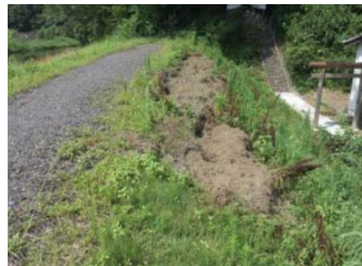
写真 3-8 イノシシによる堤防被害状況
