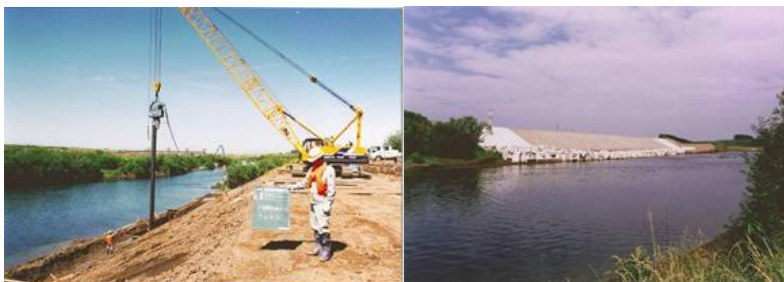
写真 6-15 鋼矢板打ち込み状況
