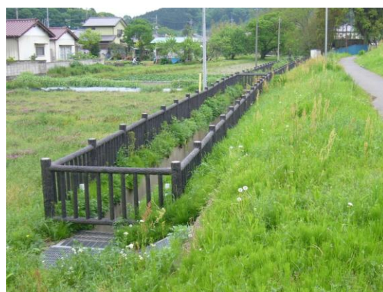
写真 6-36 堤内水路（桐生川左岸濁沼用水）
