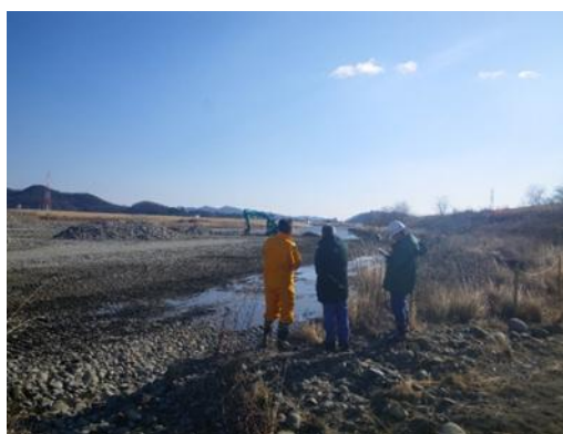
写真 6-1 河道整正による流下断面の確保 (渡良瀬川 38k 付近)
