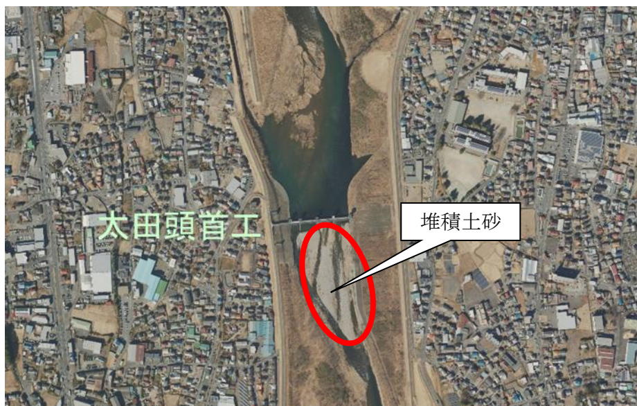
写真 3-4 太田頭首工上流部における砂州の発達 (R7.1 撮影)
