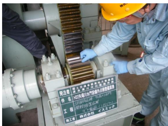
写真 6-21 巻き上げ機の点検状況
