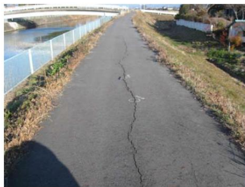
写真 5-12 地震後の点検 （矢場川第二捷水路）
