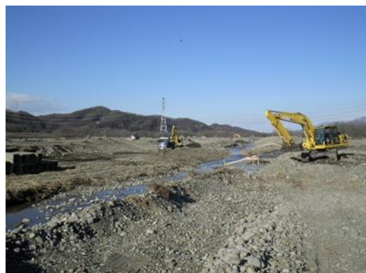
写真 6-2 河道整正による流下断面の確保 (渡良瀬川 43k 付近)
