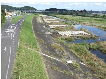
写真 6-18 水制工 (足利市緑町付近)
