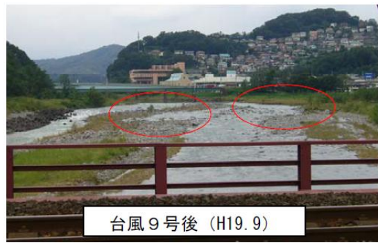
写真 6-4 出水時に流水が水路を流れ、右岸への偏流が攪乱されるようになった。
