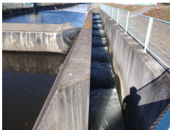
写真 6-27 羽刈堰の魚道
