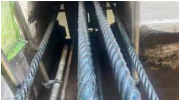
写真-6 常陸川水門ワイヤーロープグリス塗り替え
