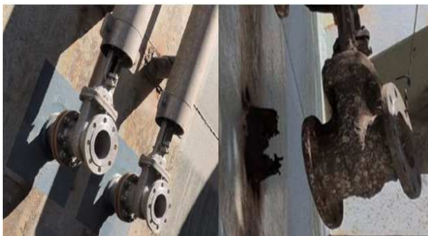
写真-7 予備ゲート部分修繕事例
