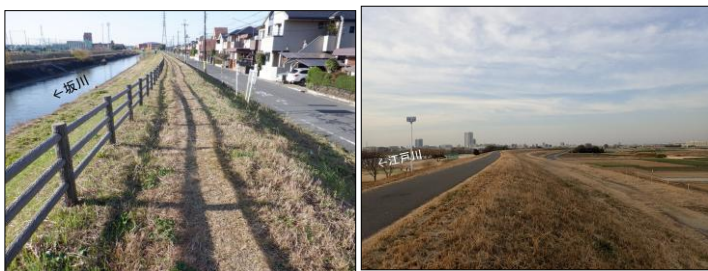
写真-1 川裏状況 坂川 (左) 江戸川 (右)
