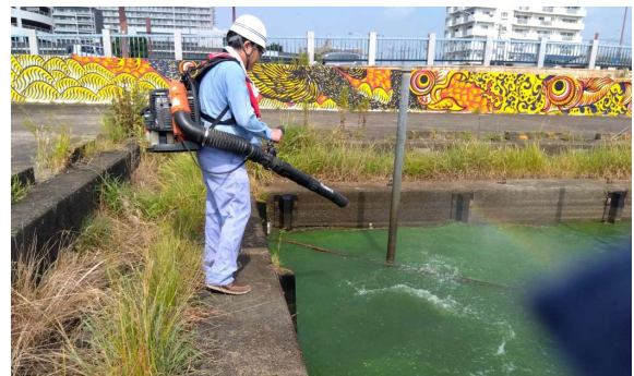
写真-5 土浦港にてブロワーでのアオコの対策実施状況
