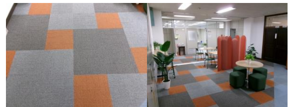
写真-6 床の色合い 写真-7 床・壁修繕後
