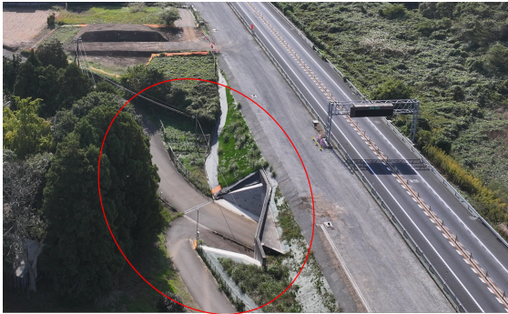
写真-1 道路改築事業に伴う機能補償道路の例
