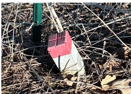
写真2 正常な境界杭と傾きがある境界杭の例
