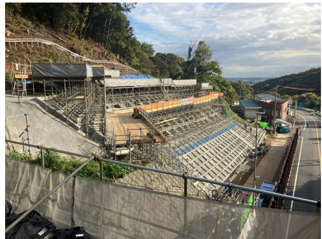
写真-3 システム足場
