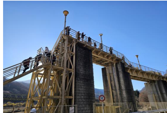
写真-2 晩秋の奥鬼怒ダム・発電所見学会(黒部ダム)
