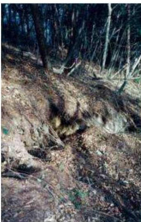
地すべり頭部に発生した亀裂
