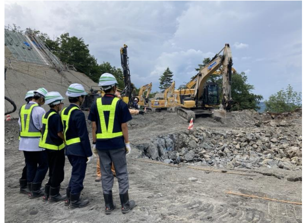
写真-6 現場見学の様子
