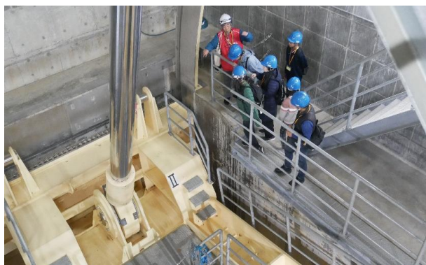
図-5 常用洪水吐を見学している様子
