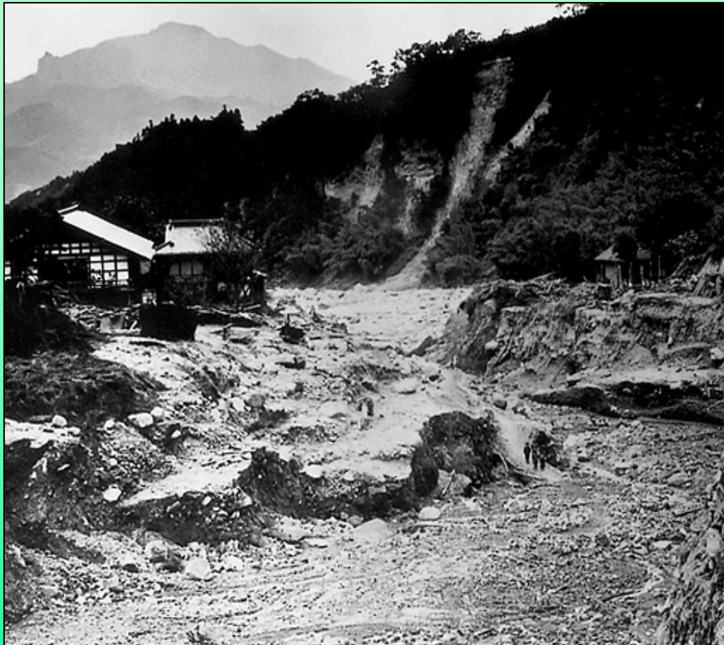
昭和22年カスリーン台風による沼尾川の被害(群馬県旧赤城村深山)
