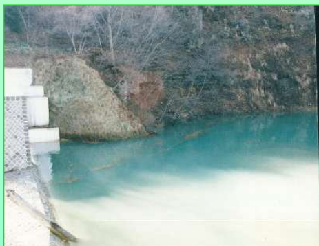
土砂捕捉前の砂防堰堤
