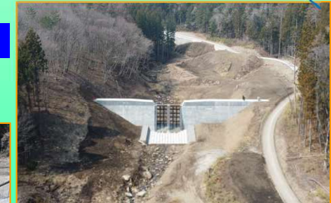
内手川第二砂防堰堤
