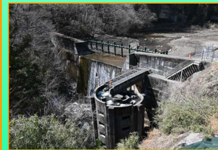
上木馬瀬砂防堰堤 (流木止め設置)
