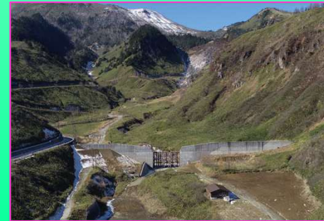
振子沢砂防堰堤
