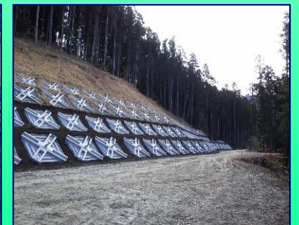
譲原アンカー工
