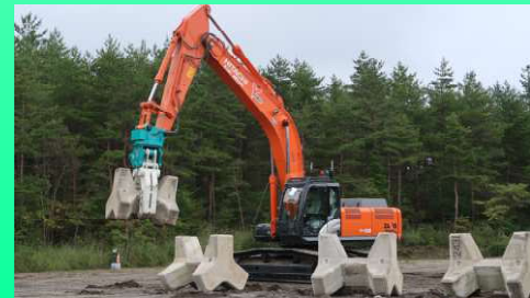
遠隔操作による無人化施工
