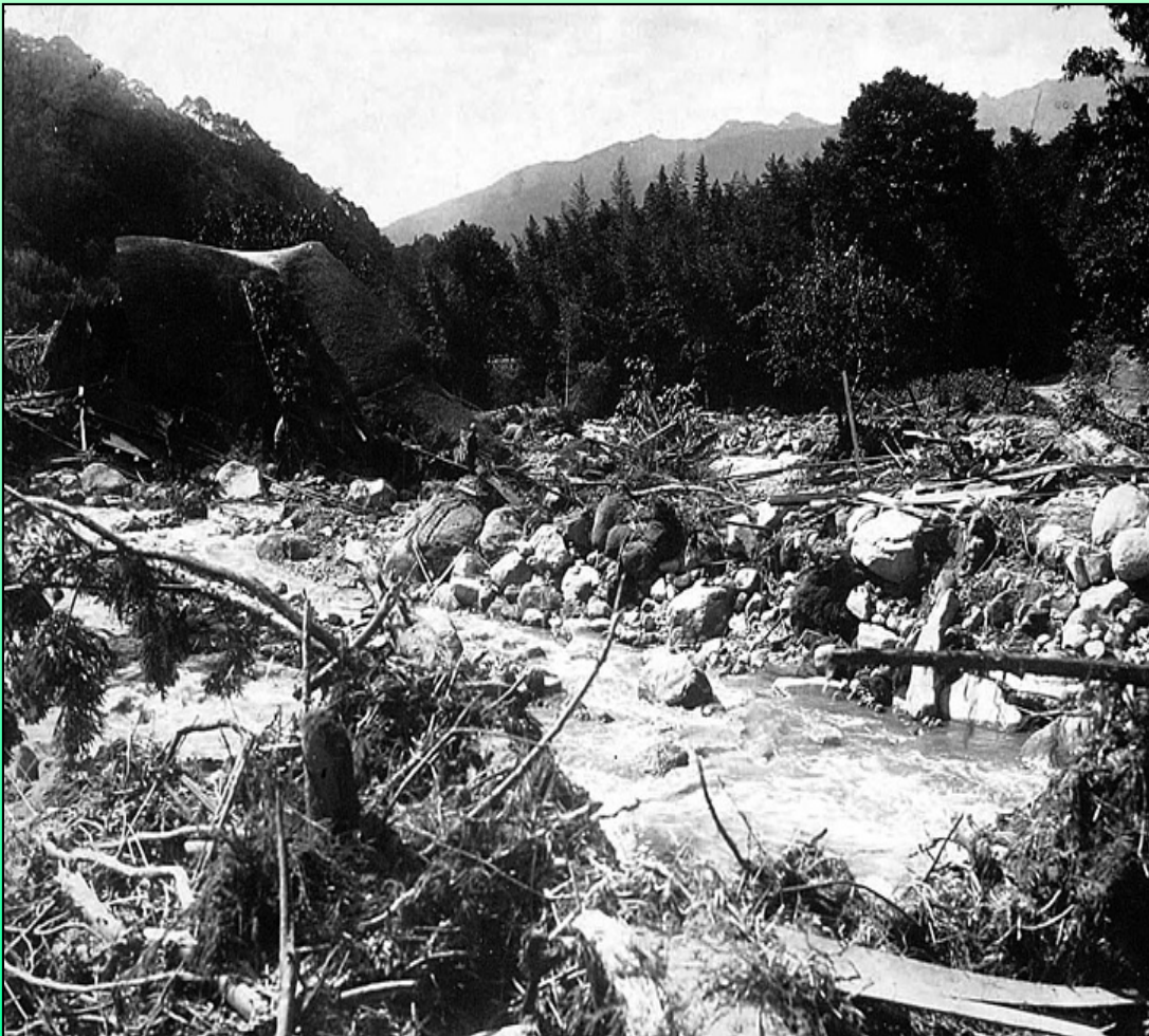
昭和10年の被害状況
