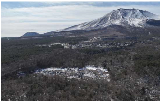
赤川第一砂防堰堤
