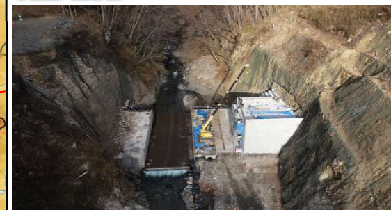
片品上流第二砂防堰堤
