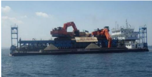
図4 二重管トレミー船による土砂投入の様子
