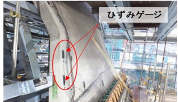
図-5 ひずみゲージ設置状況
