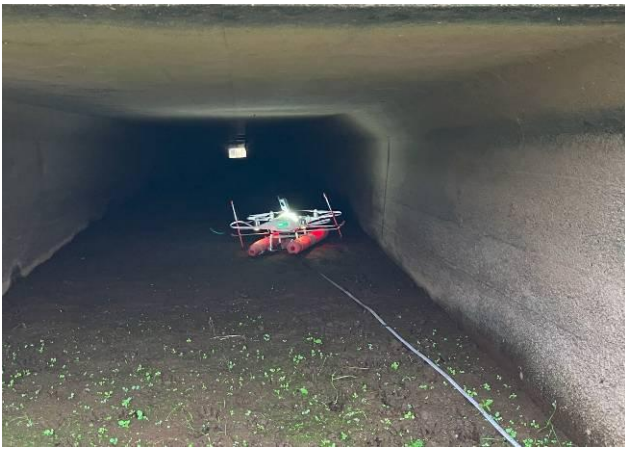
写真-6 計測状況
