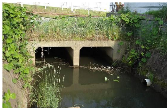
写真-2 水路状況（灌漑期）
