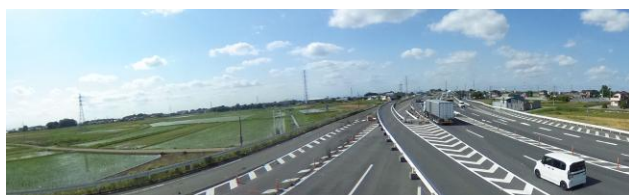
写真-1 溝橋の周辺環境
