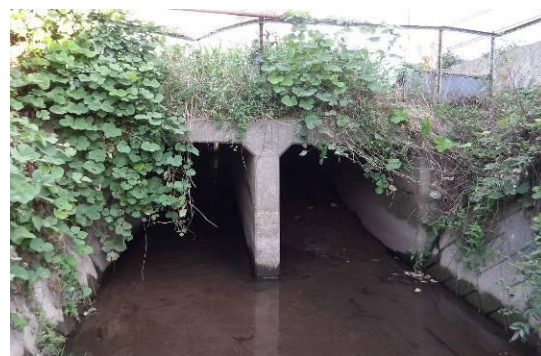
写真-3 水路状況（非灌漑期間）
