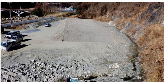
写真-7 盛土完成
