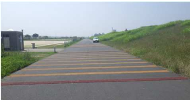
写真-5 段差舗装設置状況（上流側）
