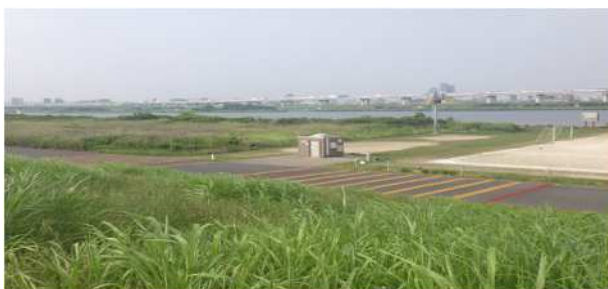
写真-4 追加施工後 全景写真
