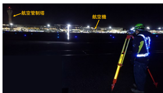
図-2 東京国際空港における夜間測量の作業状況
