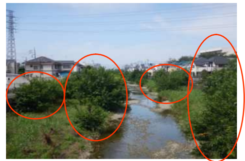
写真-1 樹木繁茂状況
