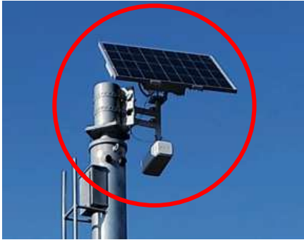
写真 1. ソーラーカメラの取付状況
