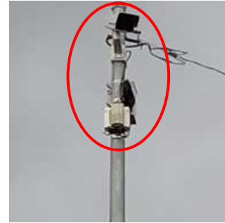
写真 2. クラウドカメラの取付状況
