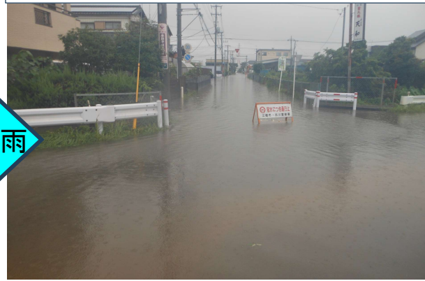
冠水状況(関東・東北豪雨)
