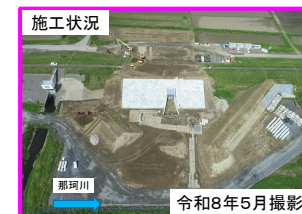
施工状況 令和8年5月撮影 ② 常陸大宮市大場地区（那珂川左岸33.5k付近）
