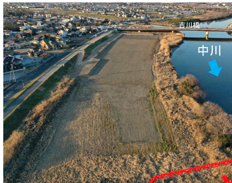
河道掘削状況
