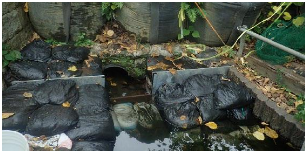
写真-3 改修工事後の四角堰（2024.11.14撮影）
