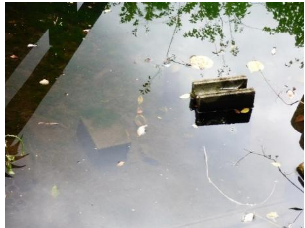
写真-4 基盤設置位置（釜部湧水口付近）（2025.7.10撮影）
