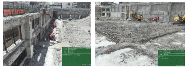
図-3 地下部分の解体写真
