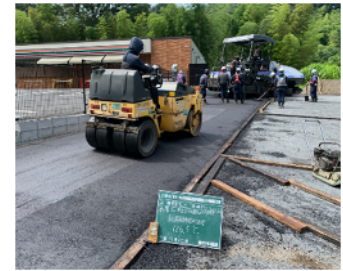
写真-2 事例②施工時状況 (2025年7月)
