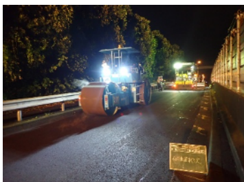
写真-3 事例③施工時状況 (2023年8月)
