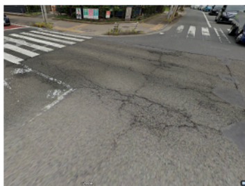
写真-1 事例①施工前 (2023年9月)
