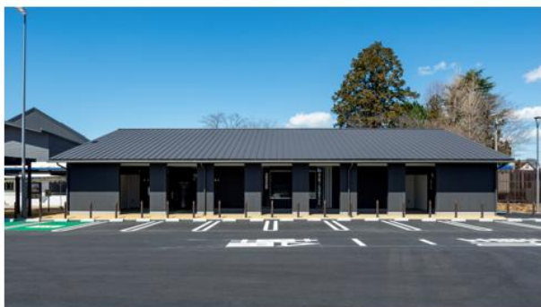
写真-2 道路休憩施設棟正面
