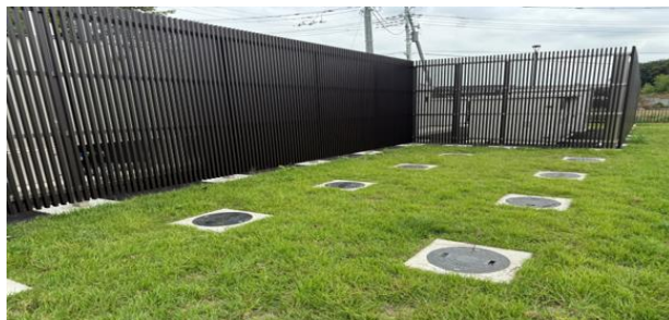
写真-5 マンホールトイレの外観
