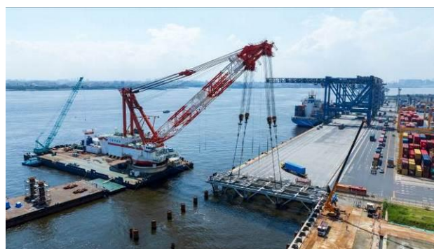
図-13 ジャケット据付状況
