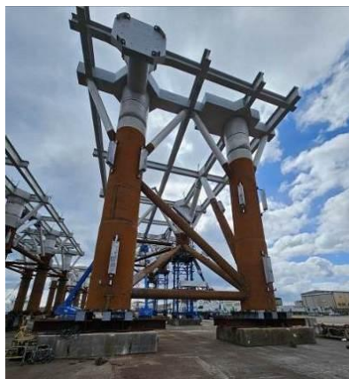
図-10 ジャケット完成
