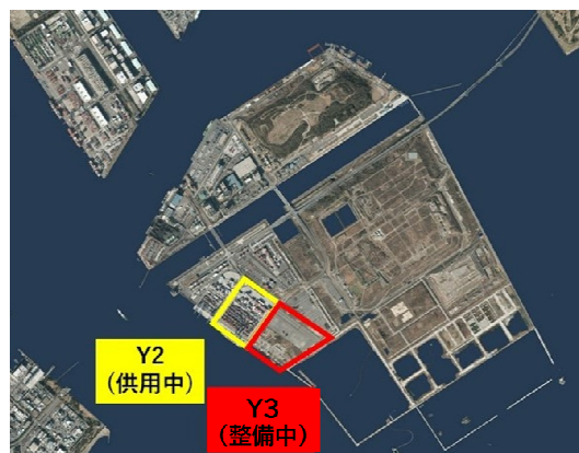
図-1 岸壁Y3整備位置
