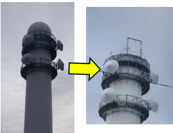
↑アンテナ・レドーム撤去後の状況
