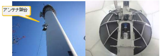
↑左：新アンテナ架台の運搬（ガイドワイヤー工法によるつり上げ）右：新アンテナ据付後
