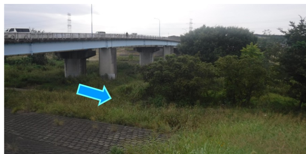
図-2 橋梁付近に樹木が繁茂している様子
