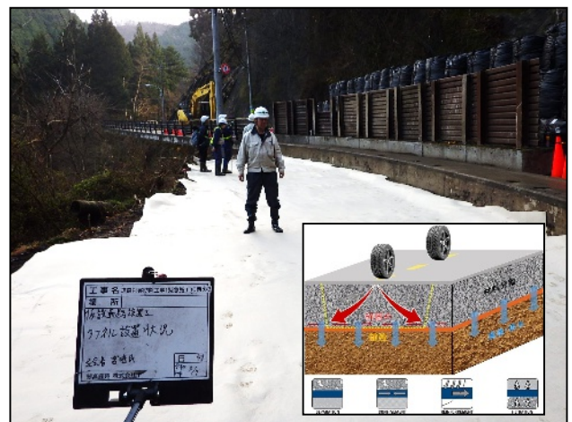
図-11 ジオテキスタイルの設置状況
