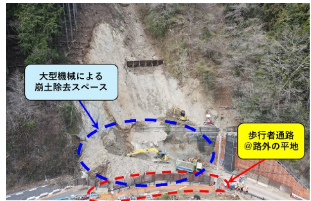
図-5 歩行者通路・仮設土留柵設置状況（空中撮影）
