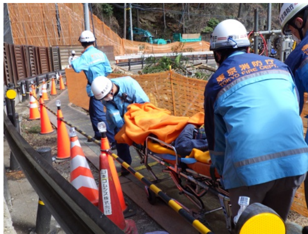
写真-14 歩行者通路を活用した救急搬送の様子
