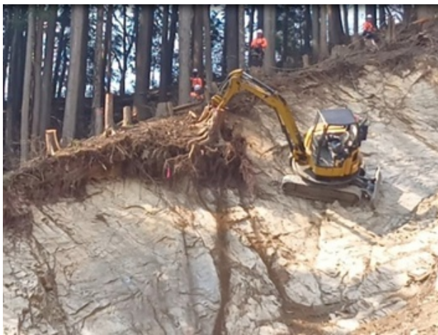
写真-8 無人化施工機械の稼働状況
