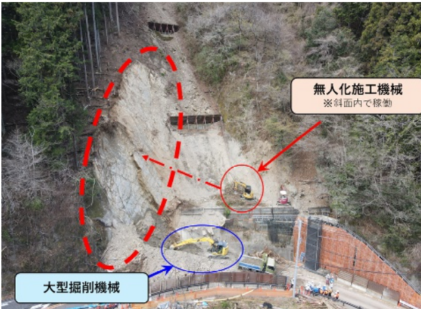
図-7 大型掘削機械と無人化施工機械の配置状況
