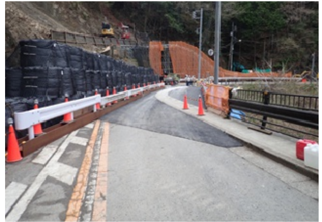
写真-9 大型土嚢擁壁の設置状況
