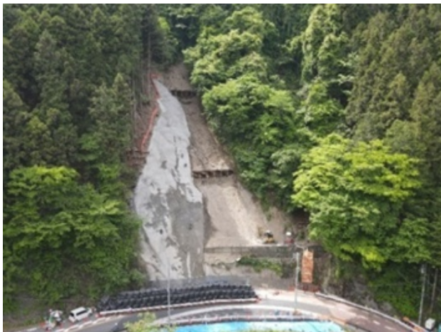
写真-12 応急対策後の斜面状況
