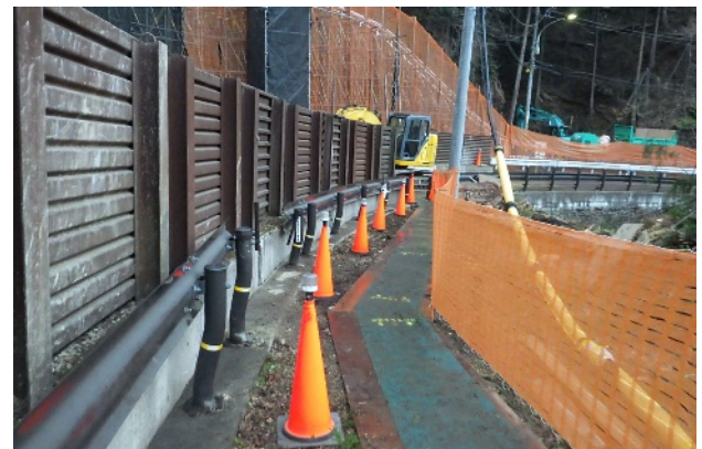
写真6 歩行者通路・仮設土留柵設置状況（地上撮影）
