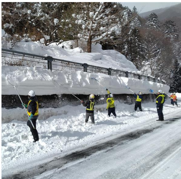
図4 雪庇処理作業中の様子（2025年2月11日 三国峠）
