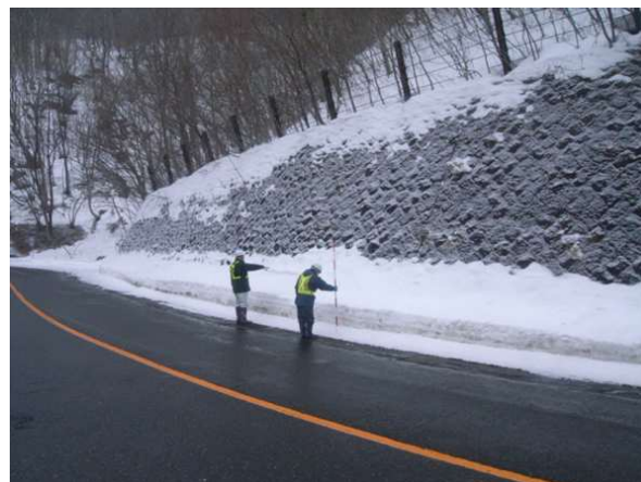
図5 防災カルテ点検の様子
