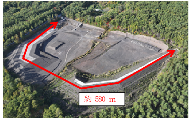
図-3 森林内で整備を進める濁川第一砂防堰堤
