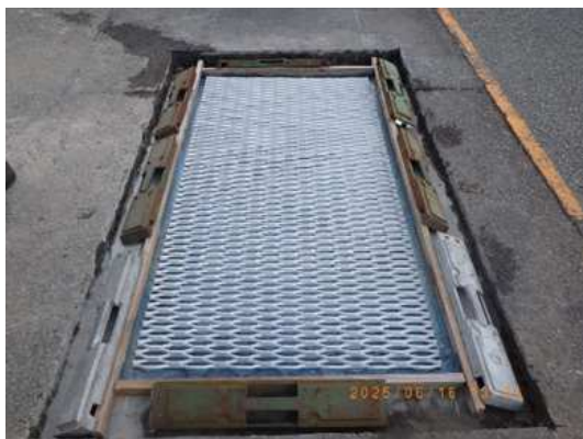
写真-8 エキスパンドメタル設置状況
