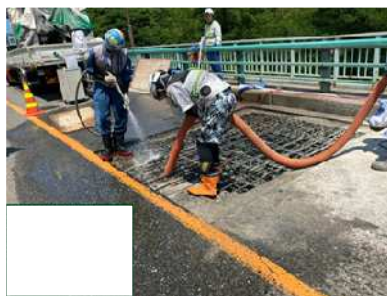
写真-2 床版コンクリートの除去状況
