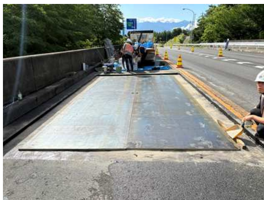
写真-4 敷き鉄板敷設状況
