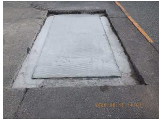
写真-9 無収縮モルタル施工状況
