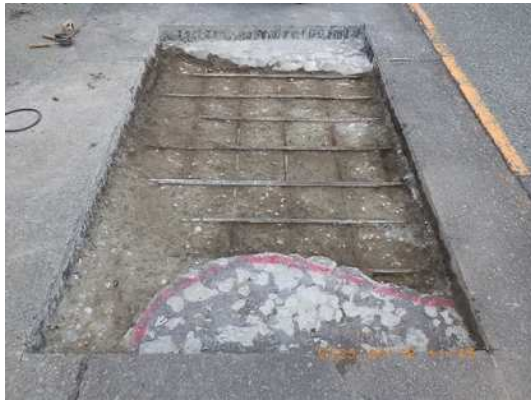
写真-7 床版劣化箇所除去状況
