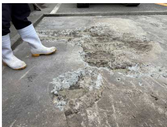
写真-3 床版劣化箇所除去状況
