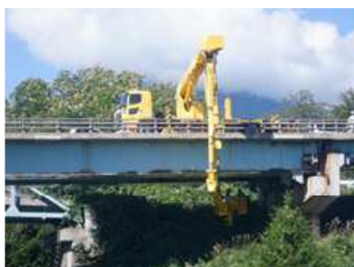
写真-1 点検風景
