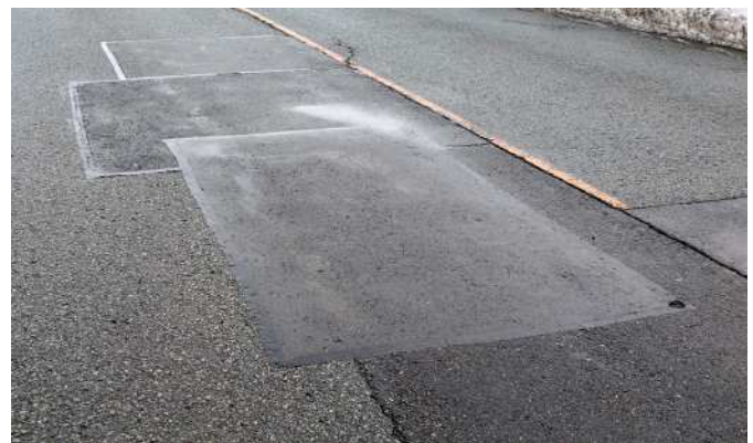
写真-10 施工から8か月後の状況
