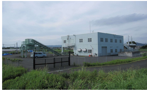
写真-1 姥川排水機場
