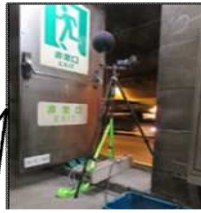
写真-2 地上扉の音圧測定機器
