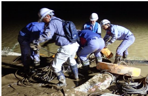
写真-1 令和元年台風19号・茨城県水戸市内
