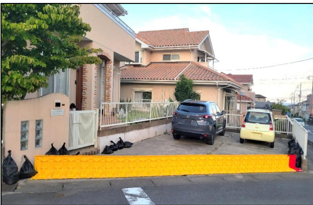
図-5 防水板設置状況
