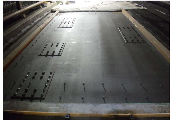
3- (1) 当て板設置後の鋼床版
