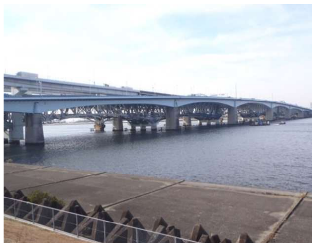
写真-1 荒川河口橋の外観（山側から撮影）
