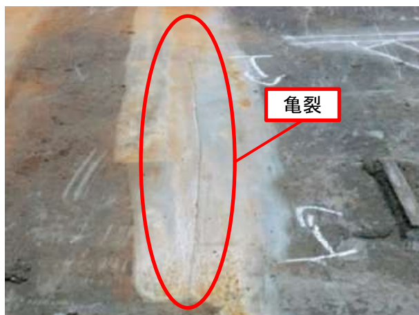
2- (1) デッキプレートの疲労亀裂
