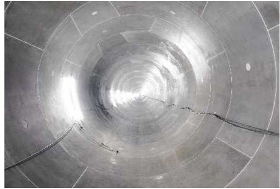
写真-6：完成後の石岡トンネル(第4工区)
