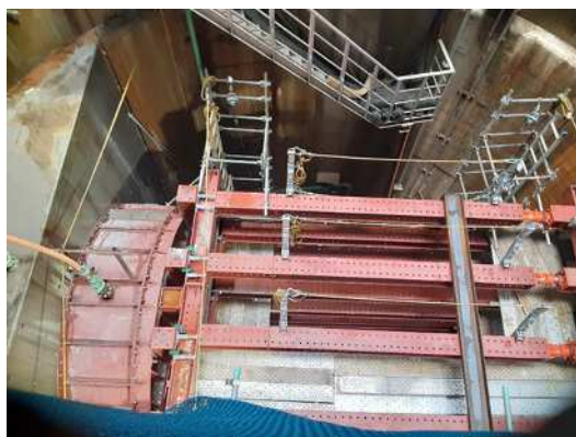
写真3：受け入れ室設置工法（流動性処理土）
