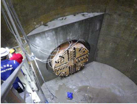
写真-5：泥の溜まり状況
