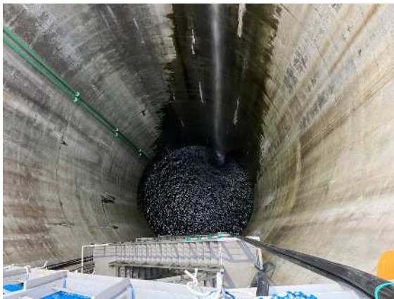
写真2：到達立坑内への水充填実施
