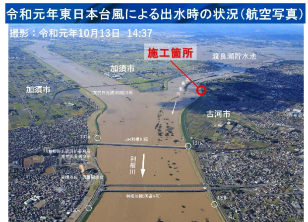
写真-1 施工箇所
