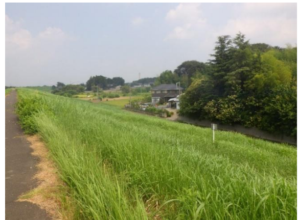
写真-2 天端から川裏方面を撮影した写真
