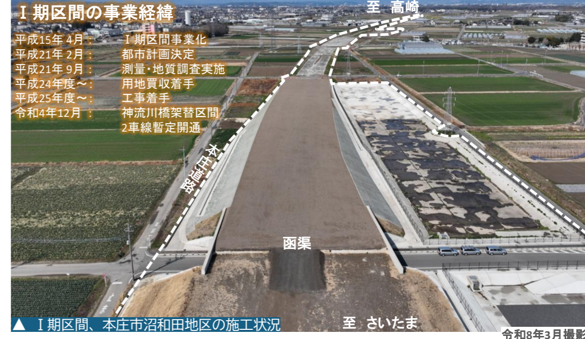
▲ I期区間、本庄市沼和田地区の施工状況 至 さいたま 令和8年3月撮影
