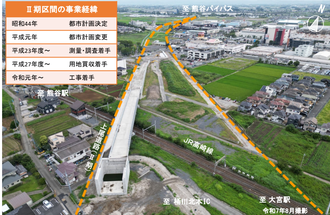
▲Ⅱ期区間空撮（鴻巣市から行田市方向を望む）
