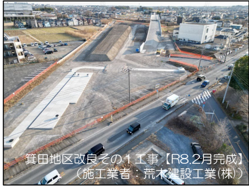
○水路工・貯留槽など
