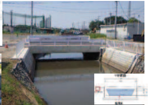
【下流側からの景況】
