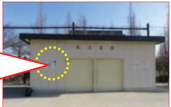
(防災活動拠点となる公園の防災倉庫)
