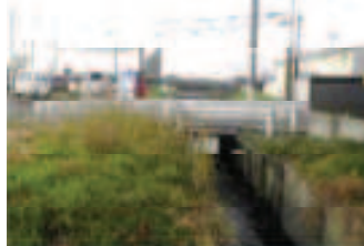
【着工前の状況】
