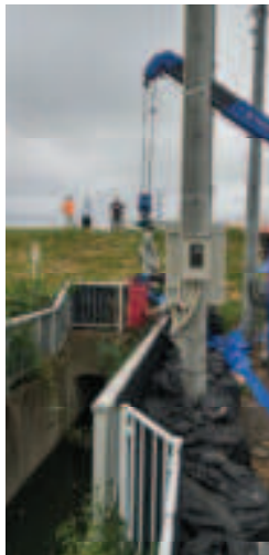
排水ポンプの設置
