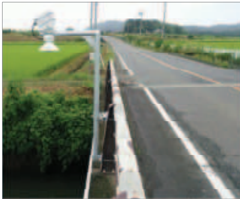
危機管理型水位計 一級河川蓮華川(栃木市藤岡町)
