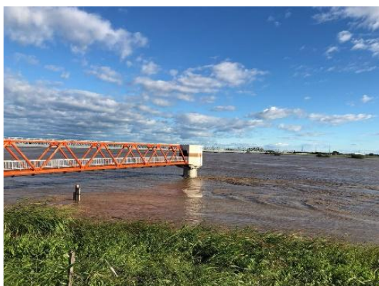
栗橋水位観測所付近(久喜市)
