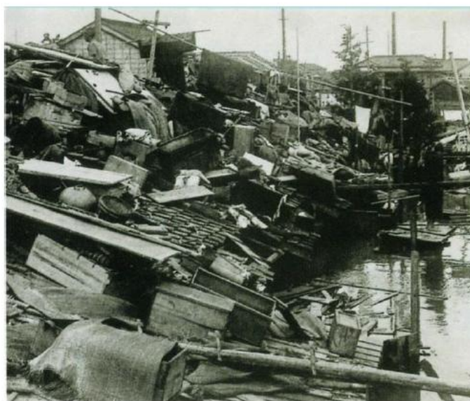
亀戸町屋上生活の惨状
