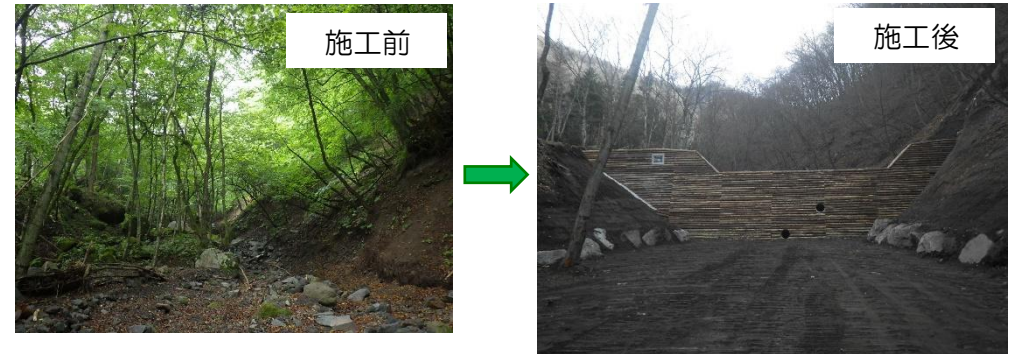
渓間工（荒廃渓流の復旧工事：コンクリート谷止工） 施工地：渋川市
