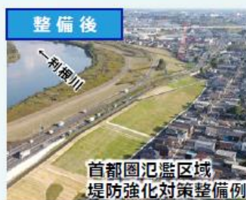
▲利根川右岸 埼玉県久喜市栗橋北地先
