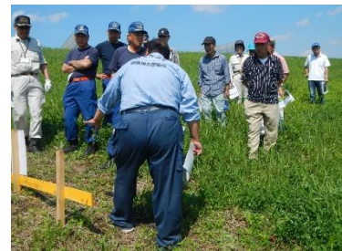
徒歩による堤防の点検
