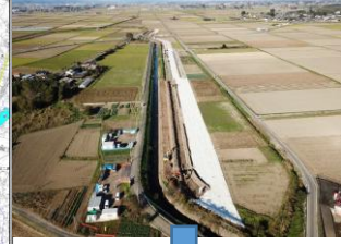
排水路の拡幅
