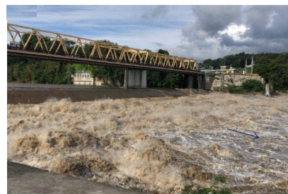
令和元年10月 利根川(渋川市半田付近)
