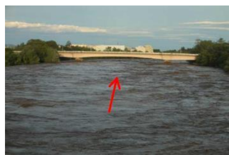
平成25年9月 利根川(玉村町上福島付近)
