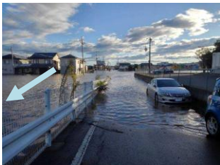
令和元年10月 被災状況
