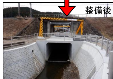
【栃木県 小藪川河道整備】
