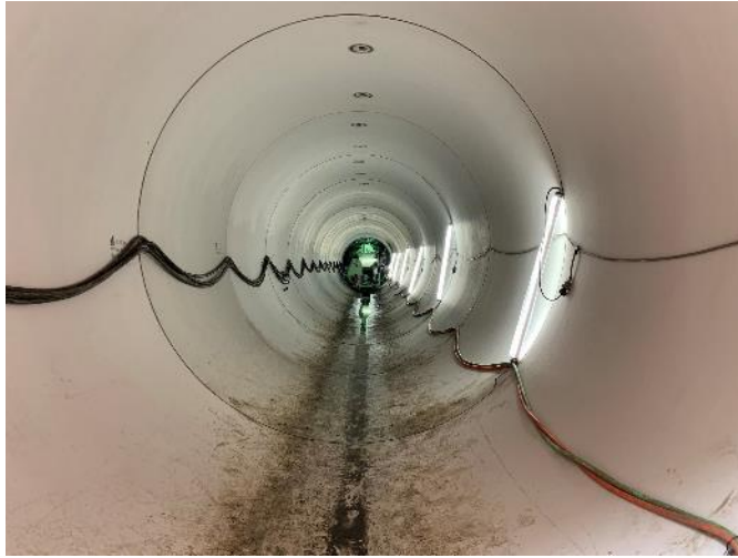
【我孫子市 柴崎雨水幹線整備】
